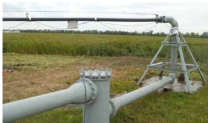
Неподвижная опора дождевальной машины
