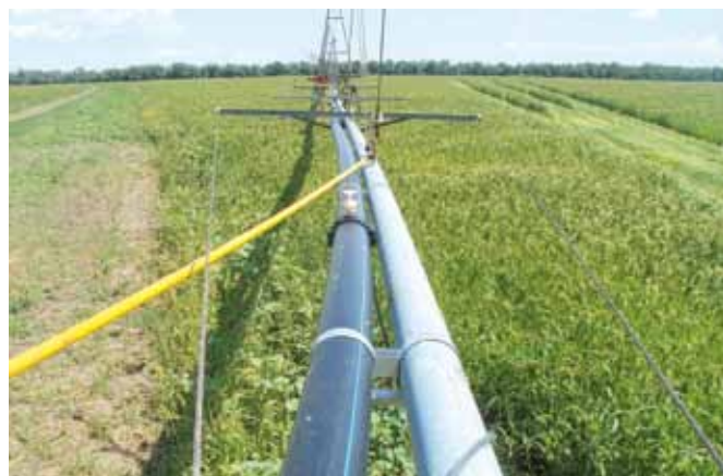
Полиэтиленовый и стальной трубопроводы
